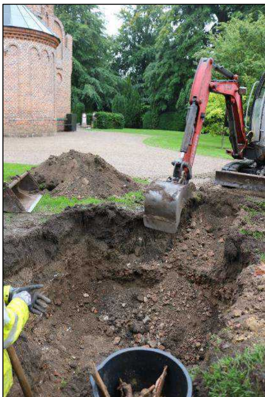
Gravning af 2x2 meter hul sydligst i 2. stræk. Med grube N1. Set mod SØ
